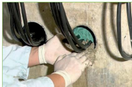
7. Die **vorderen 50 mm der Maueröffnung werden nun mit Mörtel** ausgefüllt. So wird ein sauberer Abschluss geschaffen, hinter dem die Dichtmasse quellen und sich verpressen kann. Mörtel sorgfältig zwischen die Kabel modellieren.
