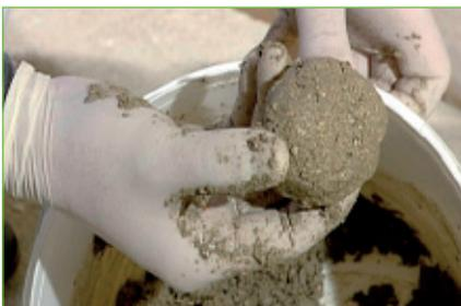
6. Der **Schnellmörtel** wird mit wenig Wasser angerührt, bis die Masse gut modellierbar ist.
