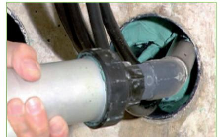
5. **Hohlraumfreies Ausfüllen** der Maueröffnung bis auf eine **Resttiefe von 50 mm**. Beginn der Füllung immer auf der Aussenseite, dann im Prozess des Füllvorganges die Spritzpistole immer weiter zurück nehmen.
