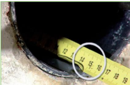
3. **Schaumband oder -stopfen** 150 mm tief in die Wandöffnung schieben. So wird eine Sperre nach außen für die Dichtmasse gebildet - möglichst auch zwischen den Leitungen.
