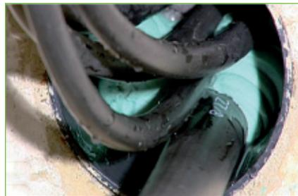
4. Kabel und Rohre möglichst auseinander biegen, so dass die **Masse zwischen die Leitungen** gespritzt werden kann.
