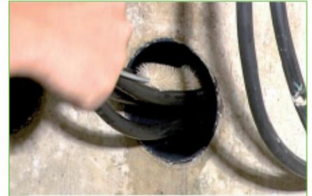
2. Mauerdurchführung und Leitungen **reinigen**. Trocknung nicht erforderlich.
