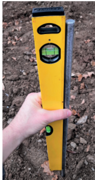
Erdspieß mit Wasserwaage positionieren und senkrecht einschlagen. Fixierung mittels der Flügelschraube M12.
