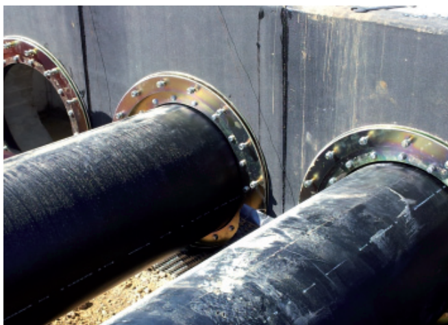
Beispiel Ringraumdichtungen mit Fest-Losflansch
