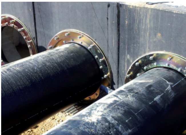
Beispiel Dichtungen mit Fest-Losflansch
