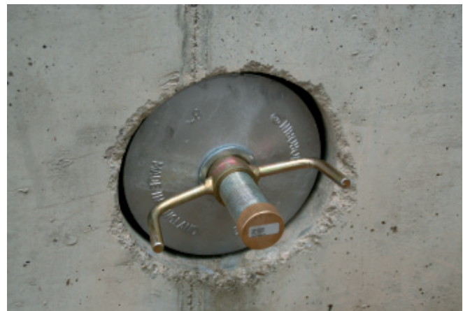
Aqua Stopper als Verschluss von Kernbohrungen
