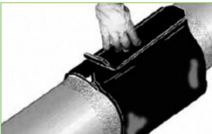
Die Schrumpfmanschette wird nun **von der Mitte nach außen ringförmig erwärmt**. Eine weiche Propangasflamme sollte verwendet werden, um den Schlauch gleichmäßig durchzuwärmen und die Werksumhüllung möglichst nicht zu verletzen.
