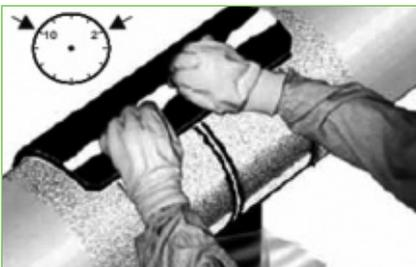
Nun wird **die Manschette mittig über die Verbindung gelegt**, beim herumlegen wird die Schutzfolie entfernt. Die vorgeschriebene **Überlappung zur Werksumhüllung ist nach DVGW Merkblatt GW15 beidseitig mindestens 50 mm**.
