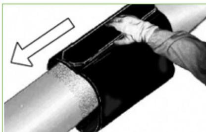
Wenn die Manschette **glatt** an den Rohr- und Verbindungskonturen **anliegt** und der **Schmelzkleber an beiden Seiten gleichmäßig ausgetreten** ist, ist die Montage beendet.
