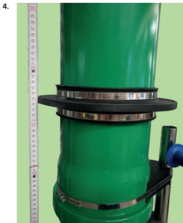
Kontrolle der korrekten Höhe des Mauerkragens
