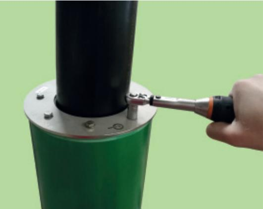
Ringraumdichtung zusammen mit dem Zentrierring in die FW-Hauseinführung schieben, bis der Dichtungsflansch bündig aufliegt.
