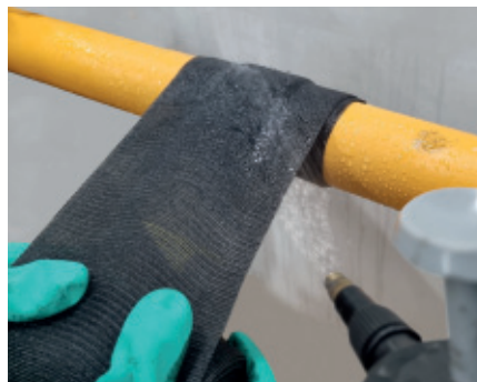
5. Pipecoat Plus mittig über das Schubsicherungsband in der geforderten Anzahl an Lagen mit 100 % Überlappung wickeln. Beim gesamten Wickelvorgang durchgehend bewässern
