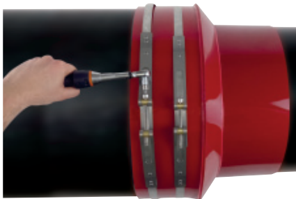
4. Zweites Spannband mit 10 Nm befestigen (austretende Dichtmasse verstreichen).
