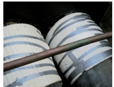
Vor dem Einsanden Manschette mit Dehnpolster schützen!
