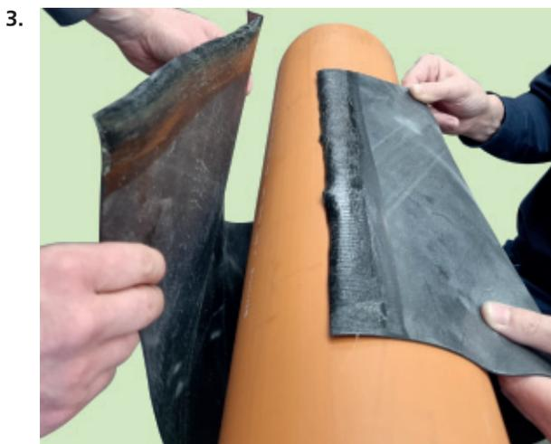
Nach dem Antrocknen der Klebeflächen wird die AKO-Manschette um das Medienrohr gelegt.
