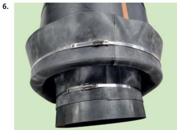
Anschließend wird die Manschette eingestülpt und am Medienrohr mit dem Edelstahlspannband befestigt.
