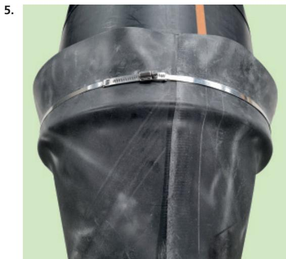
Das große Ende der Manschette wird auf das Schutzrohr gezogen bis sie stramm sitzt und mit dem Edelstahlspannband befestigt.
