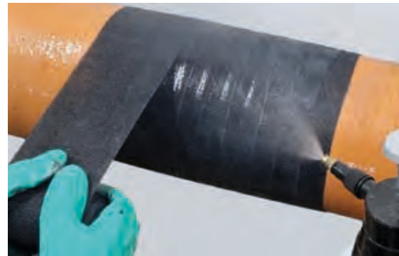
4. Wickeln des Pipecoat Plus-Bandes mit min. 75% Überlappung (4 Lagen). Während des gesamten Wickelvorgangs das Band mit Wasser besprühen. Verarbeitungszeit 2-3 Minuten (temperaturabhängig).
