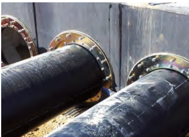
Beispiel Ringraumdichtungen mit Fest-Losflansch
