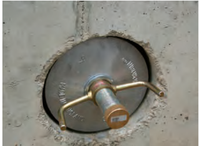
Aqua Stopper als Verschluss von Kernbohrungen
