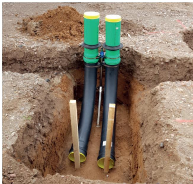
Im Bauherren-Set ist die passende 4 pipes Dichtung enthalten: **Pressio®-Ringraumdichtung Typ FW** mit Großflansch für FW-Leitungen.
