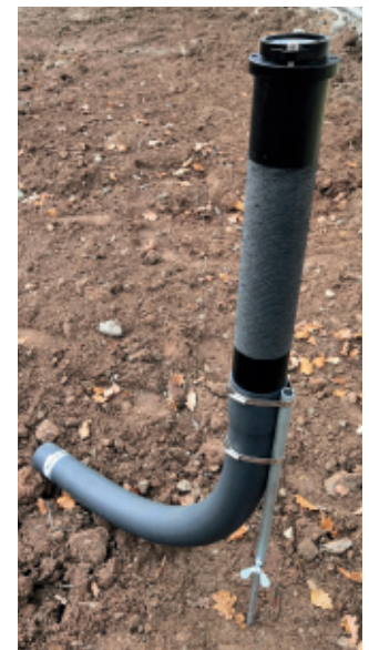
Erdspeiß mit Wasserwaage positionieren und senkrecht einschlagen. Fixierung mittels der Flügelschraube M12.
