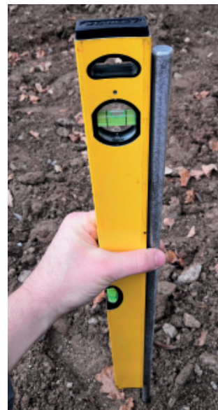
Erdspeiß mit Wasserwaage positionieren und senkrecht einschlagen. Fixierung mittels der Flügelschraube M12.
