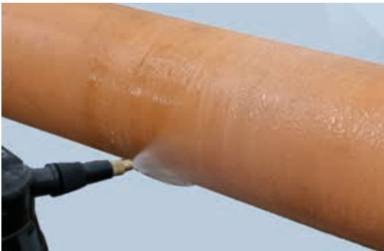
3. Rohroberfläche von Schleifrückständen befreien und anfeuchten
