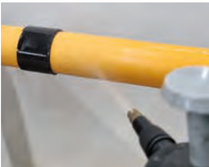
4. Oberfläche und Schubsicherungsband anfeuchten
