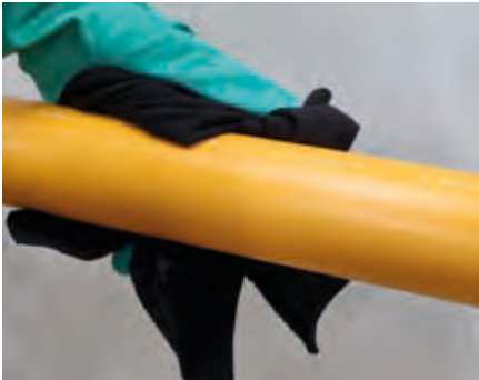
1. Oberfläche säubern, trocknen und entfetten
