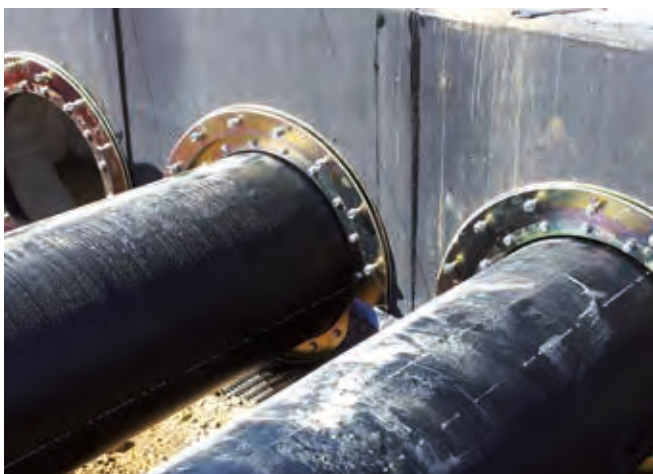
Beispiel Ringraumdichtungen mit Fest-Losflansch
