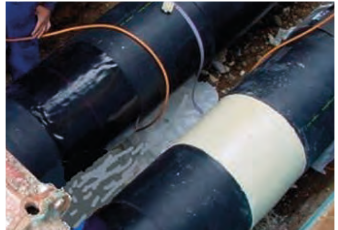
(WC-20R links – ungeschützte Dämmung rechts)
