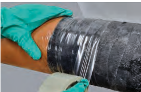
5. Mit Klebeband oder Klarsichtfolie stramm umwickeln
