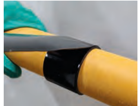
3. Rohroberfläche von Schleifrückständen befreien und Schubsicherungsband in der geforderten Anzahl an Lagen mit 100 % Überlappung wickeln
