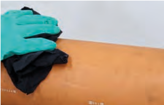
1. Oberfläche säubern, trocknen entfetten
