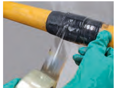
6. Mit Klebeband oder Klarsichtfolie stramm umwickeln
