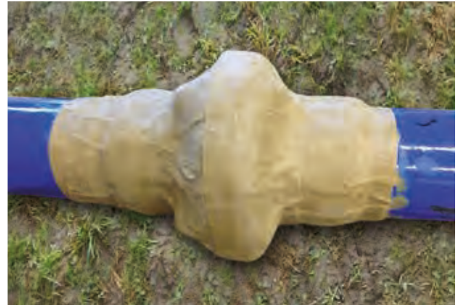
Petrolatum-Korrosionsschutzumhüllung nach EN 12068 / DIN 30672 Klasse A/30 – 2 Lagen System
