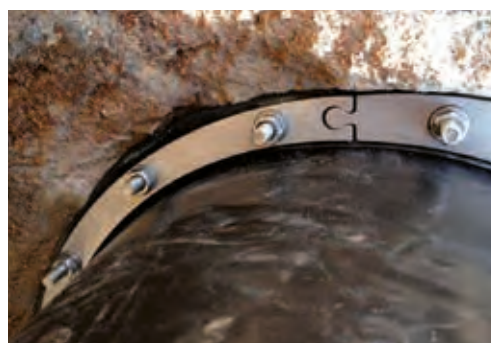
Pressio Individual, geteilt, Trinkwasser, nicht zentrisch
